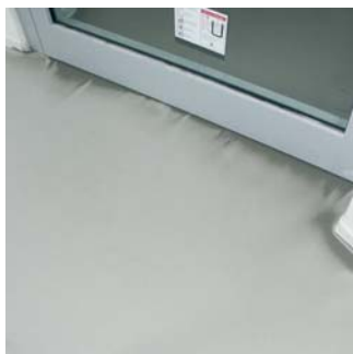
Farbänderung durch Zugluft
