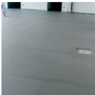
Glanzgradunterschiede in der Versiegelung
