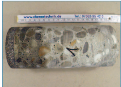
Stark verölter Beton unter Magnesiaestrich
